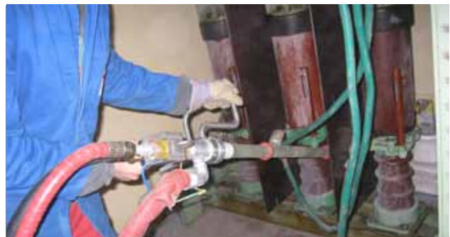
Bild 3: Reinigung spannungsführender Anlagen mit Trockeneisstrahlen
